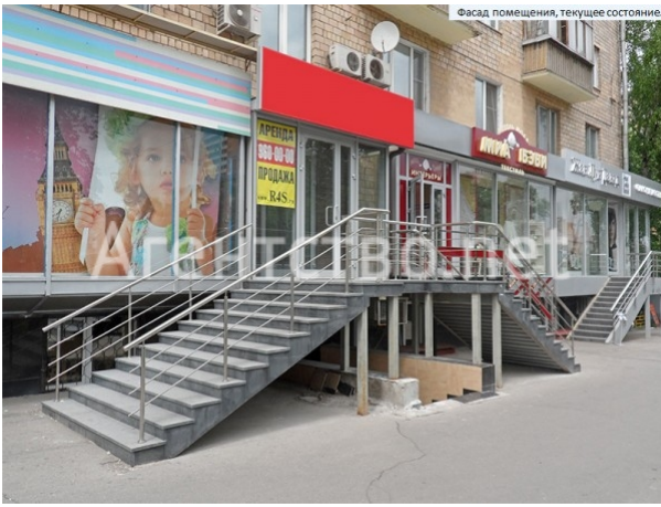
Фасад помещения, текущее состояние.
